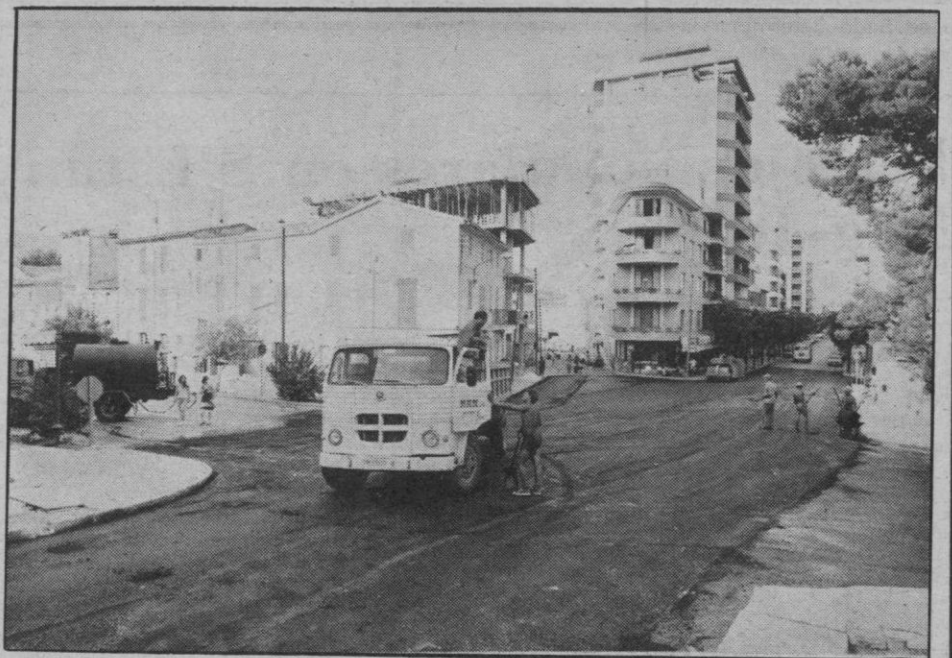
primero se pintan los pasos cebra y luego los asfaltan (Foto: Quelglas)
