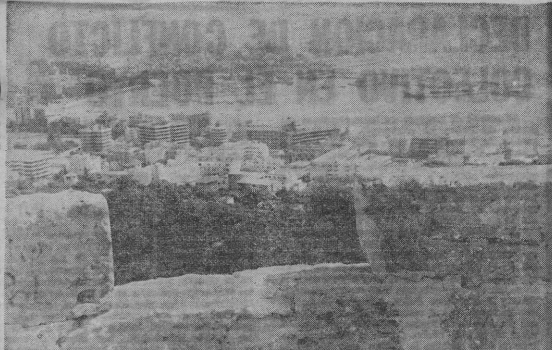
Alguno de los sillares, ya ha caído. Varios han forzado su unión a los vecinos y quedan sueltos centrifugados o impedidos por un hundimiento o abertura en las bases de la fortaleza.
