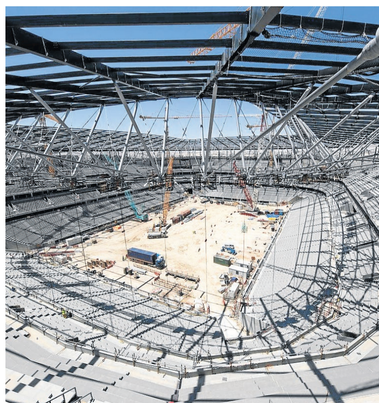
Obras en uno de los estadios para el Mundial de 2022.
