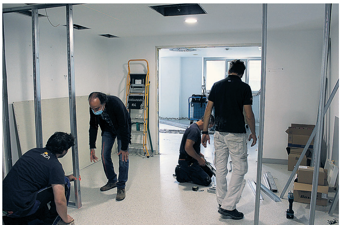
Primeros trabajos de la Unidad de Cuidados Intensivos del Hospital General.
