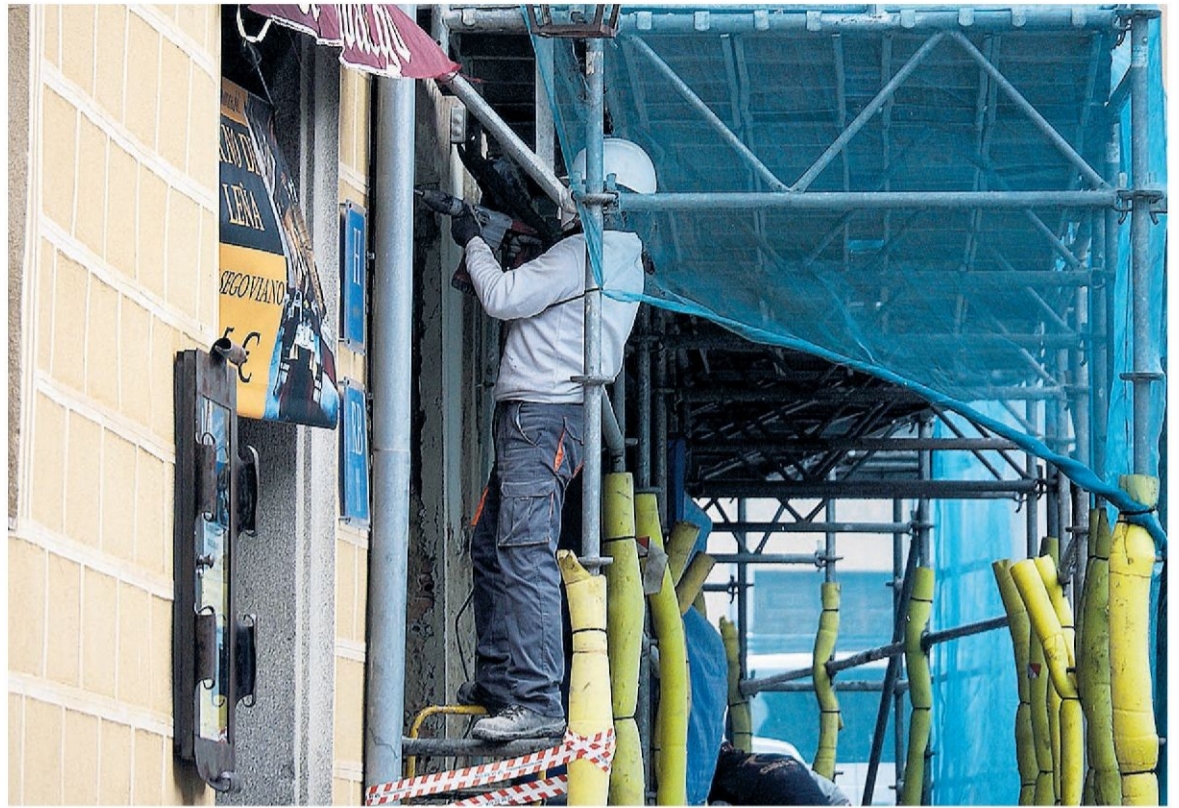
Las empresas del sector de la construcción tienen limitaciones para trabajar en edificios habitados.
