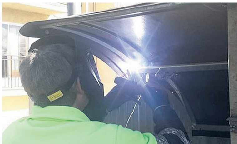
Un empleado de Valoriza realiza tareas de reparación.
