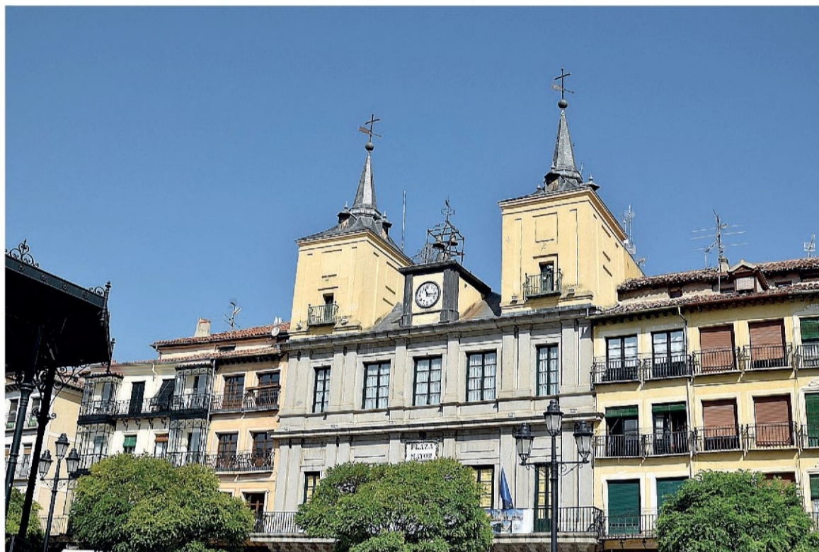
Fachada de la Casa Consistorial, en la Plaza Mayor, que contiene dos ascensores y dos salvaescaleras.
