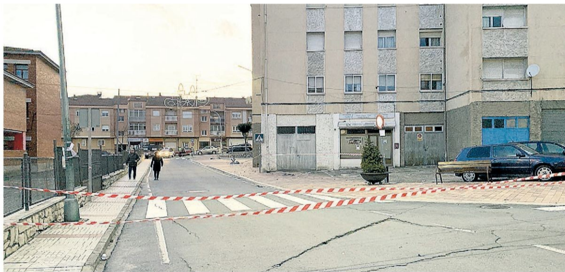
Zona acordonada por la caída de tejas por el barrio de Los Rosales.
