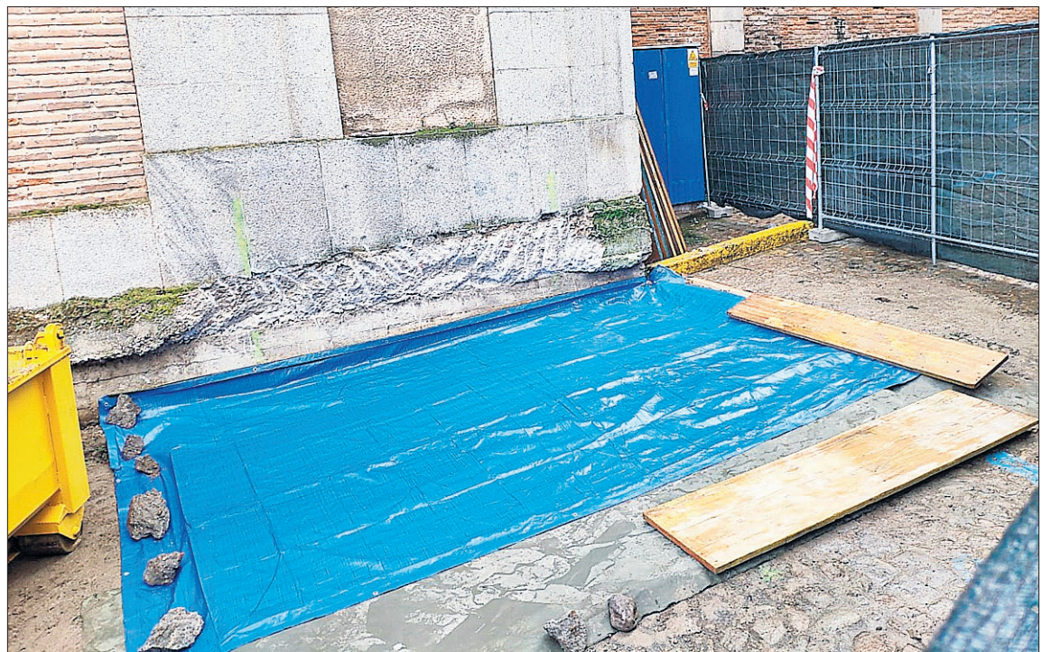
El ascensor de la calle de Gascos se está construyendo junto a las escaleras que comunican con Vía Roma. / E. A.
