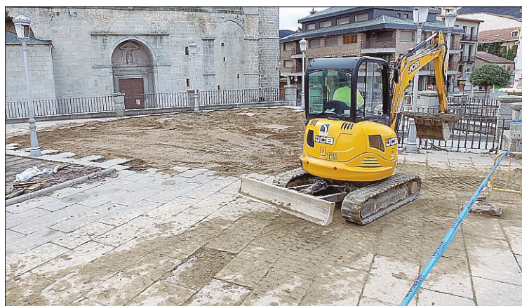
Los operarios trabajan en el arreglo del 'parking'. // JOSÉ REDONDO
