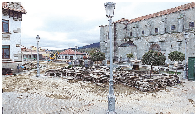
Plaza del Ayuntamiento en obras debido a la reforma. // JOSÉ REDONDO.
