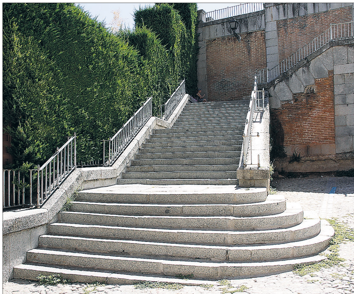
Escaleras que conectan la calle Gascos con Vía Roma y que impiden en paso de los usuarios de silla de ruedas. / NEREA LLORENTE
