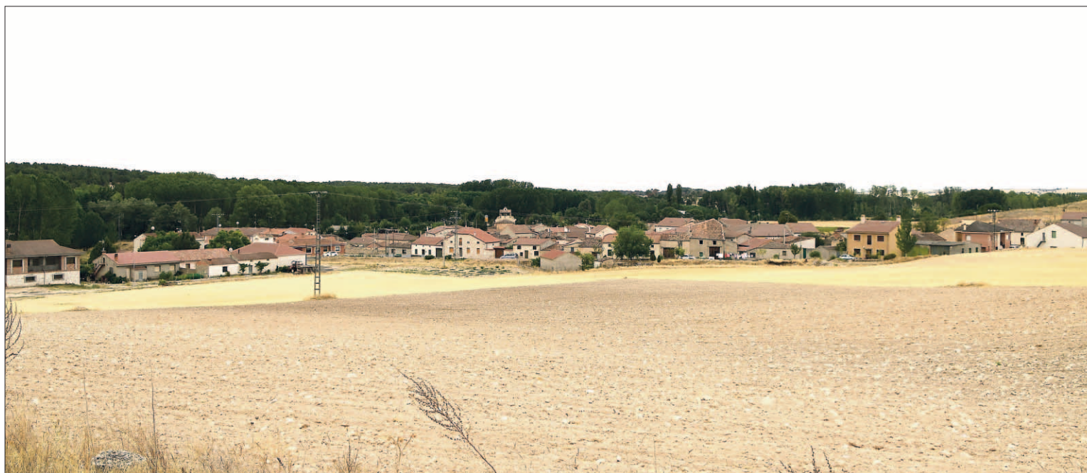
Vista general de Cobos de Fuentidueña.
