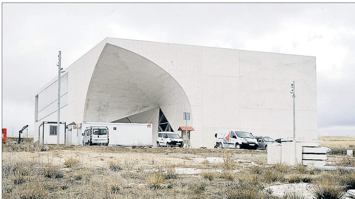
El edificio, a la espera de un nuevo futuro, debe ser reacondicionado. / KAMARERO
