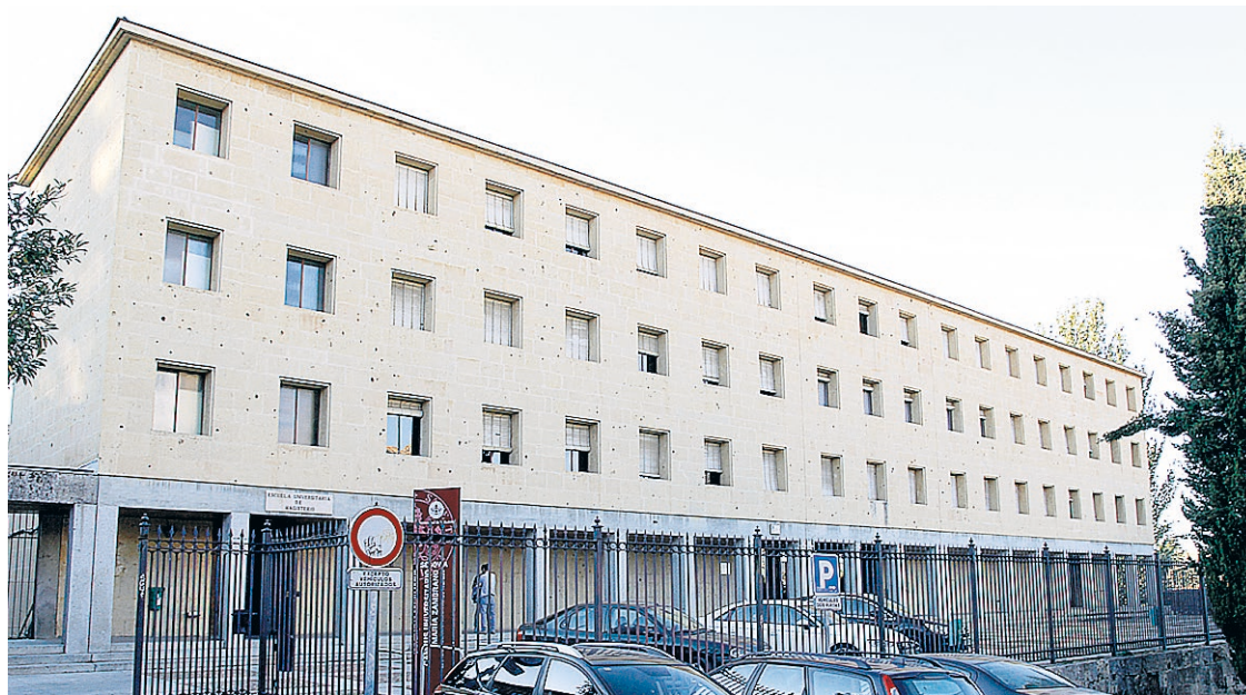
Edificio de la Universidad de Valladolid que fue Escuela de Magisterio y Escuela Normal. / NEREA LLORENTE
