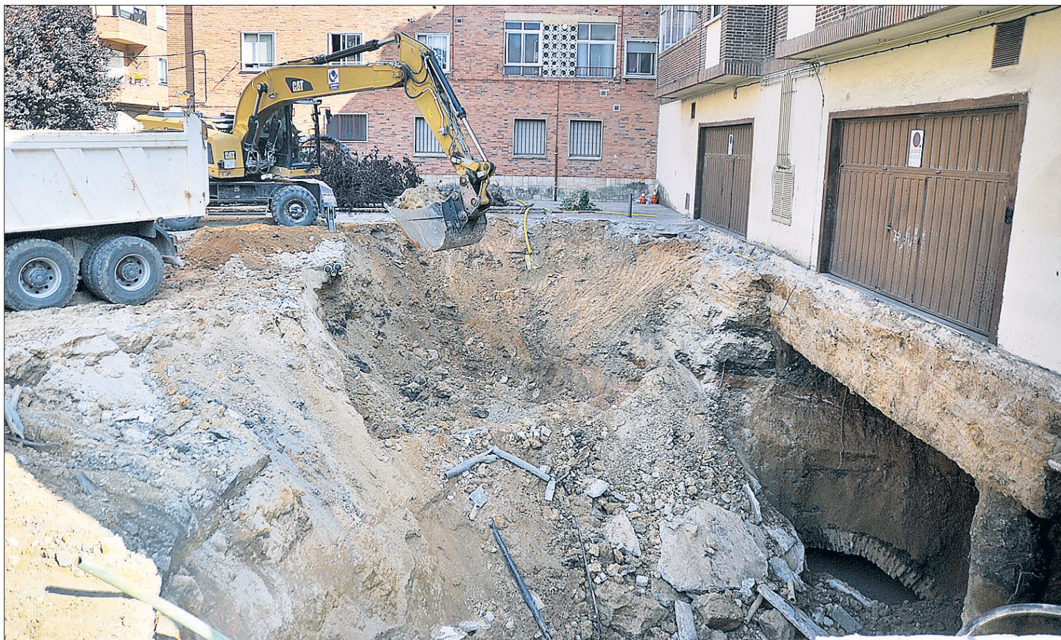
La maquinaria pesada realiza tareas de desescombro en la plaza de Aurelio Hernández, donde se produjo el socavón. / KAMARERO
