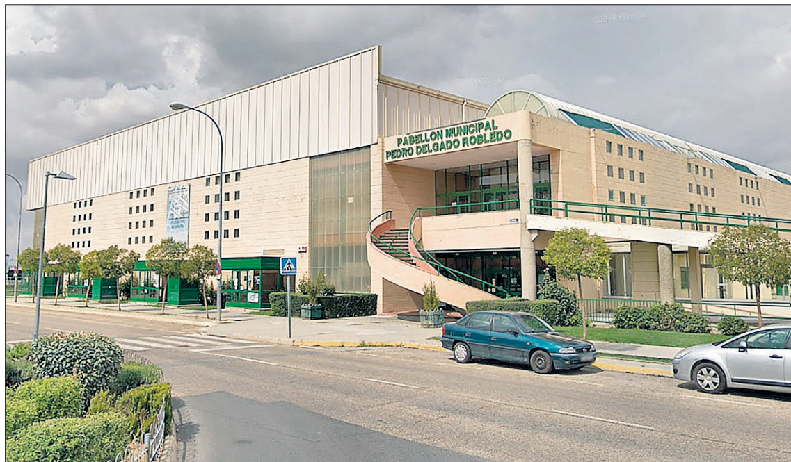
Exterior del Pabellón Municipal Pedro Delgado Robledo. / EL ADELANTADO
