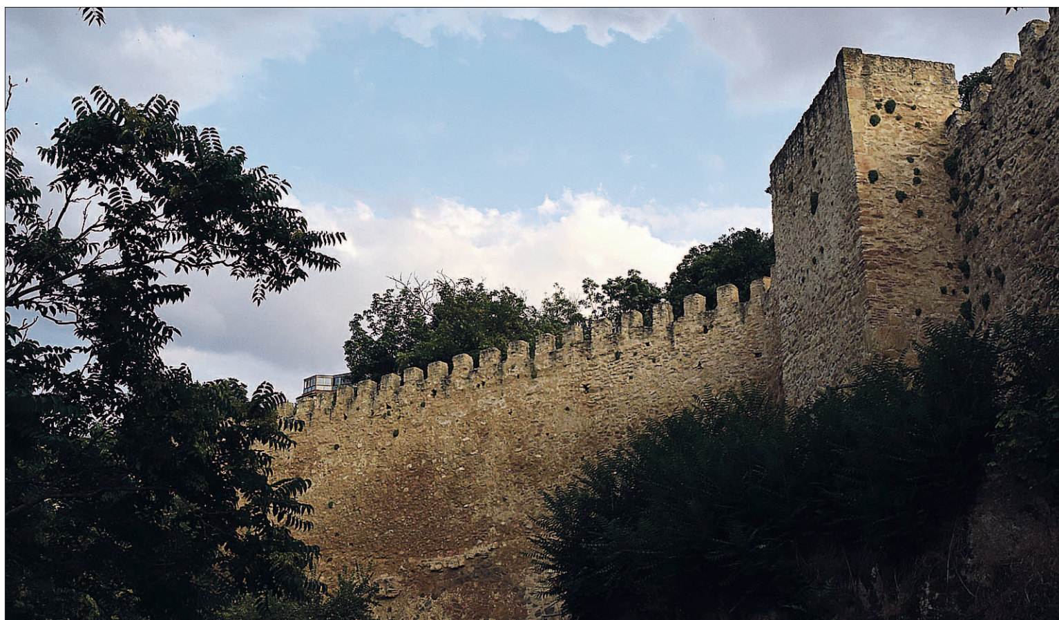
La abundante vegetación que en algunos puntos del tramo norte de la Muralla casi coloniza el monumento es un inconveniente para su conservación. / ROCÍO PARDOS
