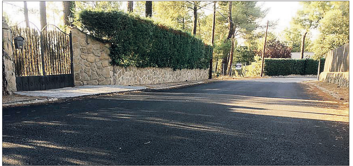
Imagen del Paseo de la Fuente del Cura, donde se redujeron los baches recurriendo a parches de asfaltado. / LUCÍA LUQUE
