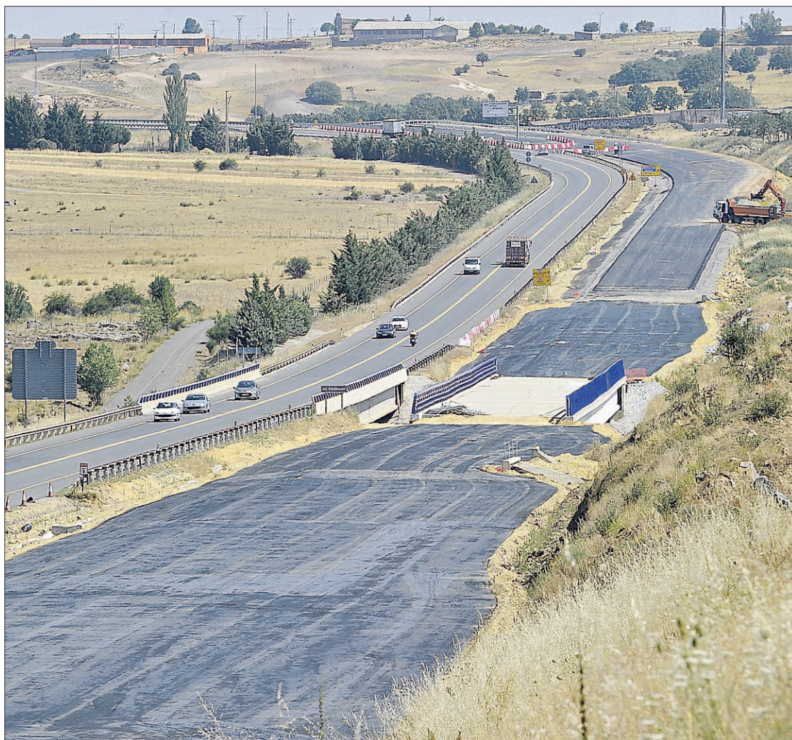
Las obras consisten en el desdoblamiento de 14 kilómetros de calzada. / KAMARERO
