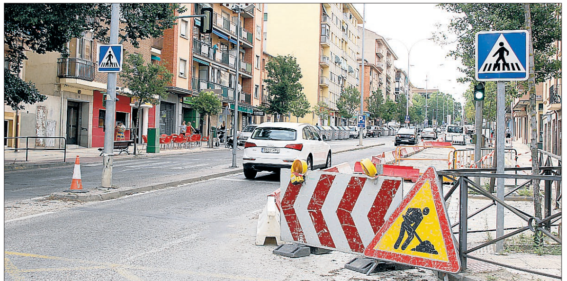
Los vehículos circulan junto a las obras en el paseo de Ezequiel González. / NEREA LLORENTE
