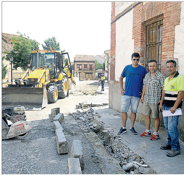
Imagen de la situación actual en la que se encuentran las obras. / LOURDES MATARRANZ
