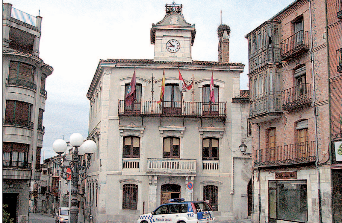
El edificio del Ayuntamiento será objeto de una de las inversiones, para acondicionar su accesibilidad./C. NÚÑEZ
