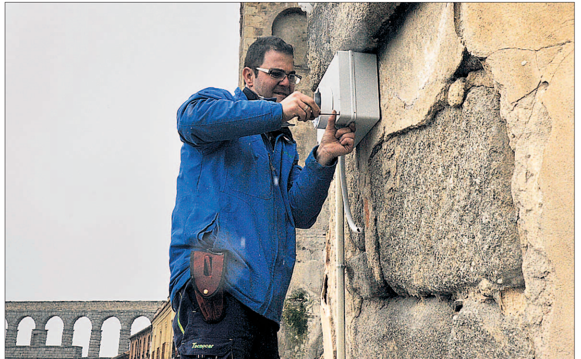
Un operario procede a la instalación del dispositivo en el muro de la Casa de las Cadenas. / KAMARERO
