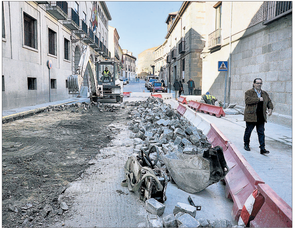
Con trabajos de excavación del pavimento comenzó ayer la última fase del proyecto de urbanización. / KAMARERO
