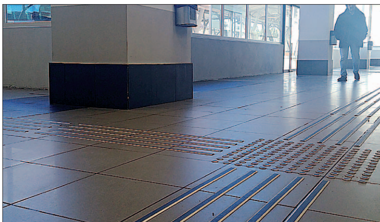
El suelo dispone de pavimento podotáctil para facilitar el recorrido a las personas con visibilidad reducida o invidentes. / E. A.
