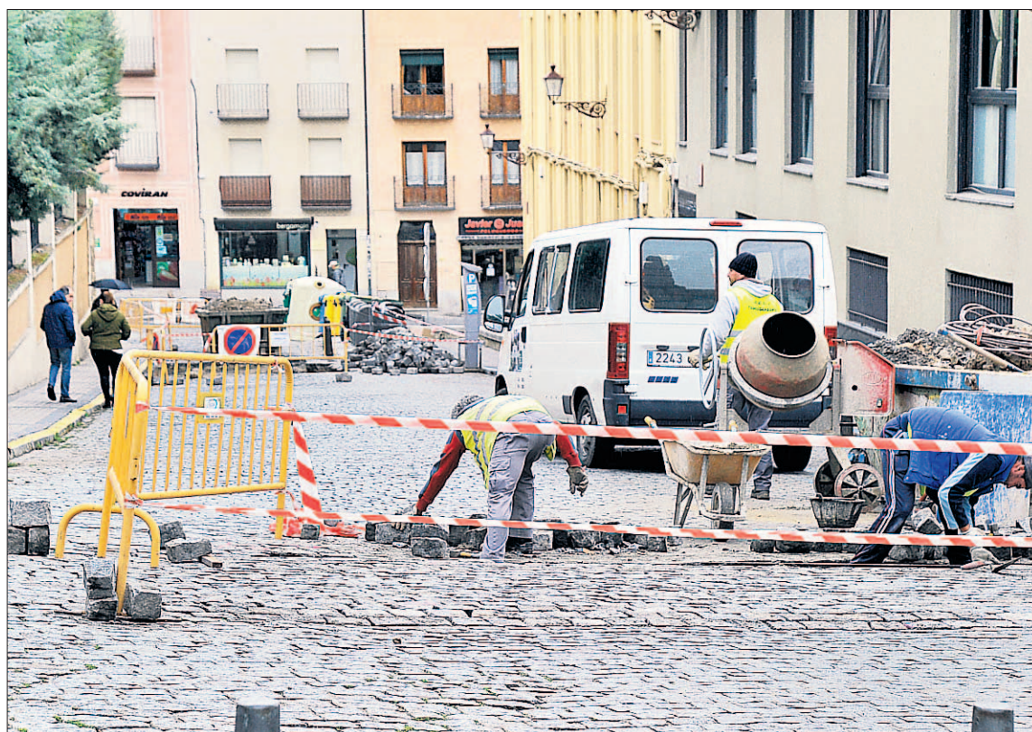
Los trabajos que se ejecutan en Pintor Montalvo tienen por finalidad reparar los hundimientos en la calzada. / KAMARERO
