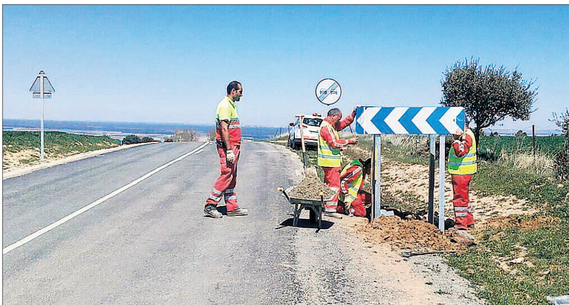
Varios operarios de la Diputación Provincial, realizando trabajos de sustitución de señales. / EL ADELANTADO
