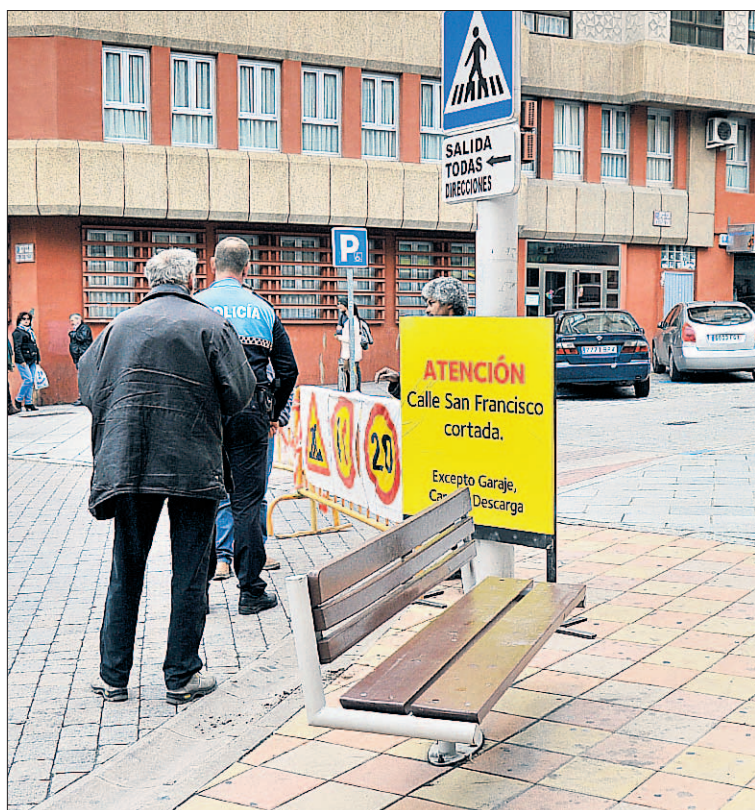
Señalización de obras en el inicio de la calle Pintor Montalvo. / KAMARERO
