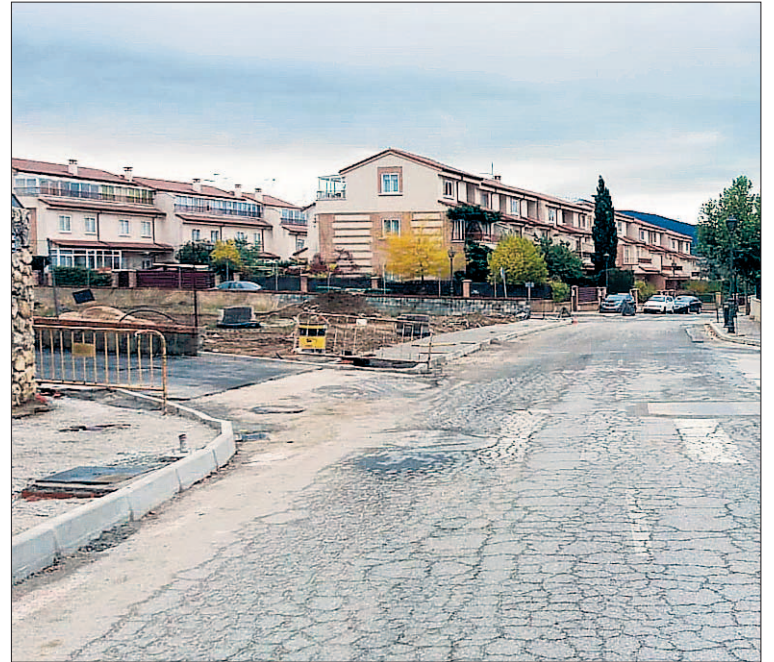
Las obras también incluyen el acerado de estas vías. / EL ADELANTADO
