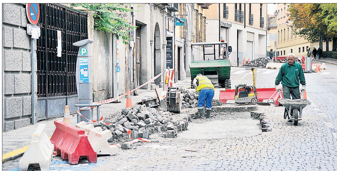
La calle San Agustín, a la altura del edificio de la Audiencia Provincial, también está afectada por obras. / KAMARERO
