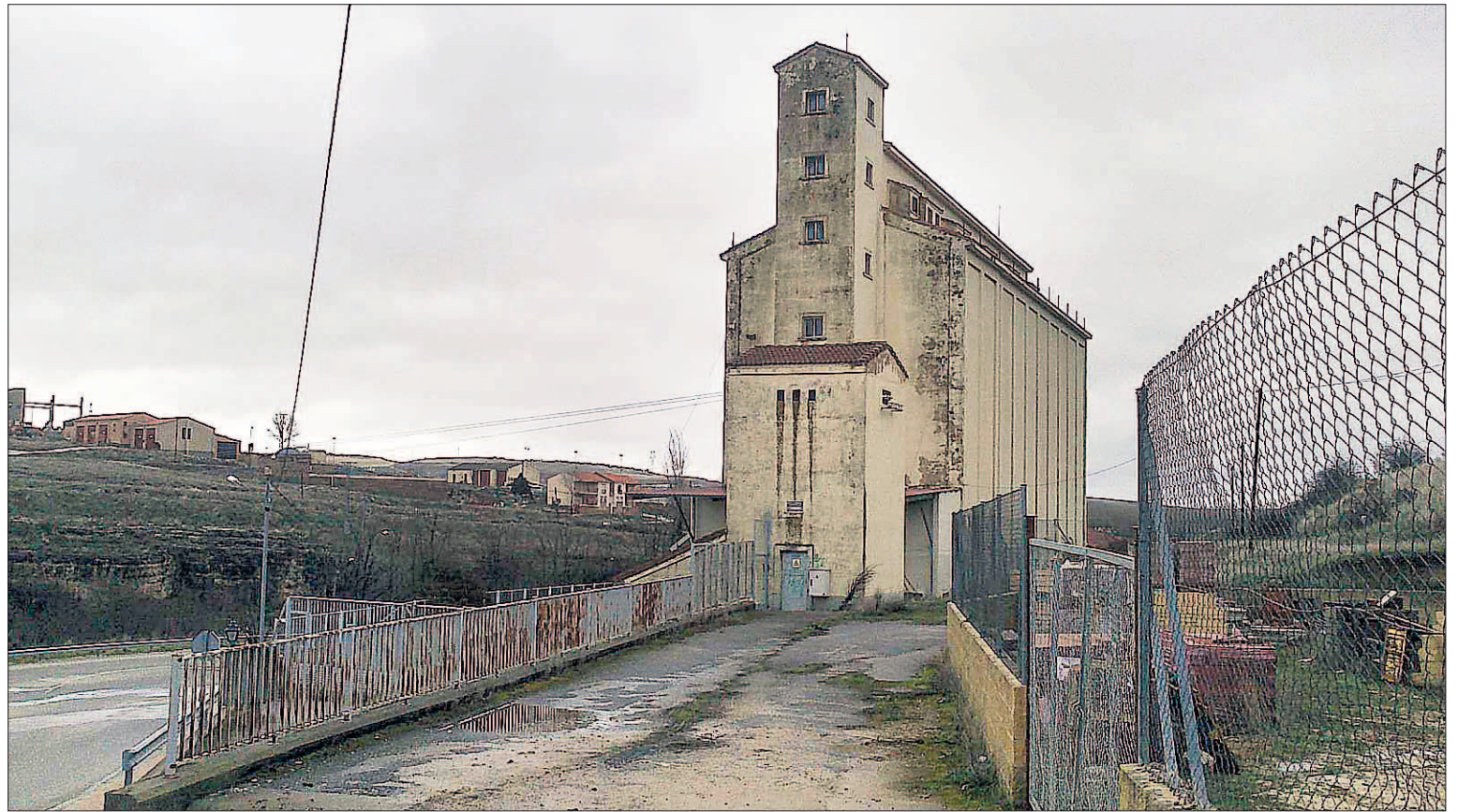
El silo y las instalaciones anexas se encuentran en la calle Isabel la Católica, en la salida hacia Boceguillas. / EL ADELANTADO
