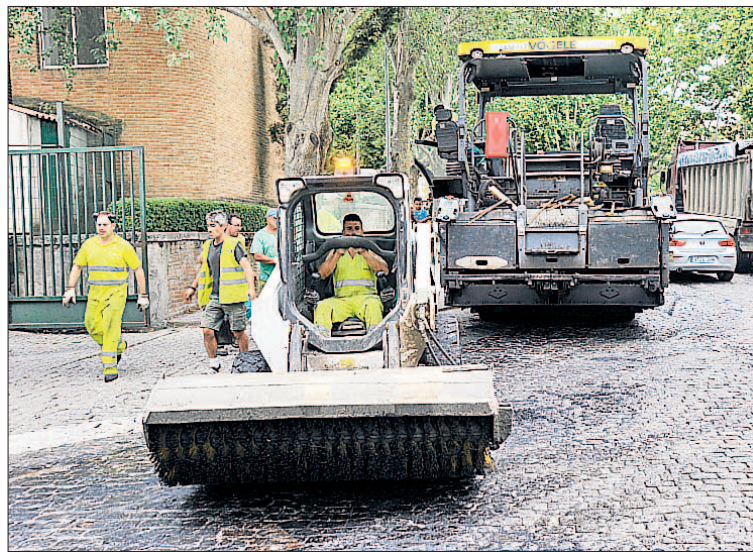
Los trabajadores llevan varios días trabajando en el asfaltado de la ciudad. / KAMARERO
