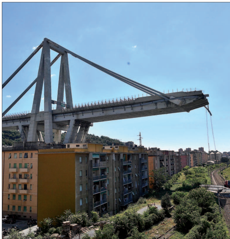
Vista de los restos del puente Morandi en la ciudad italiana de Génova. / EFE
