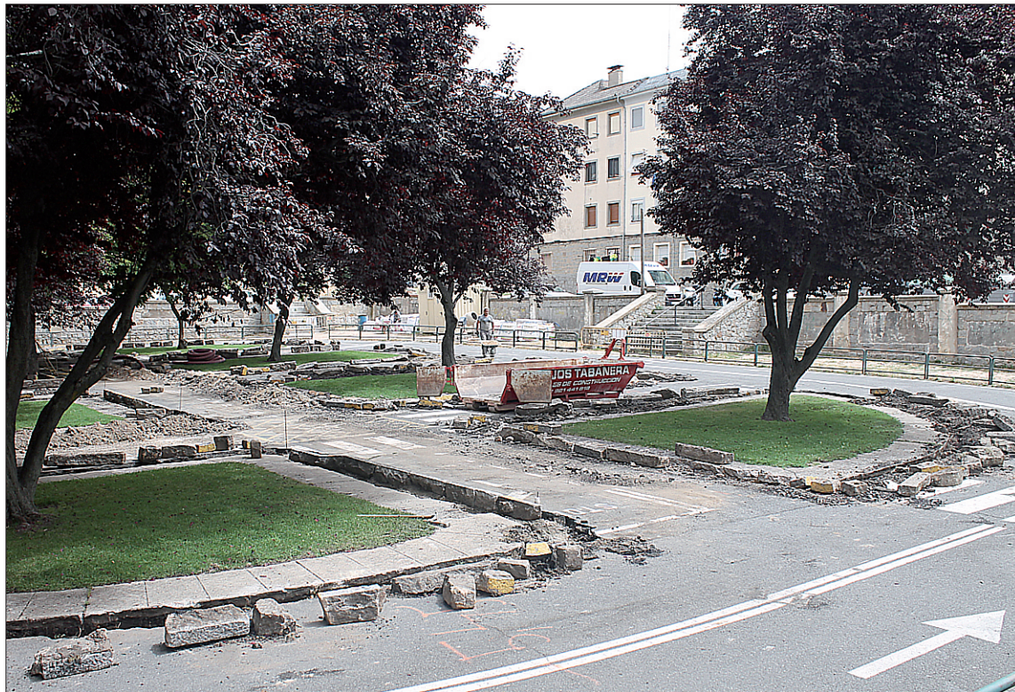
Los bordillos ya han sido levantados para su posterior reubicación. / M.G.
