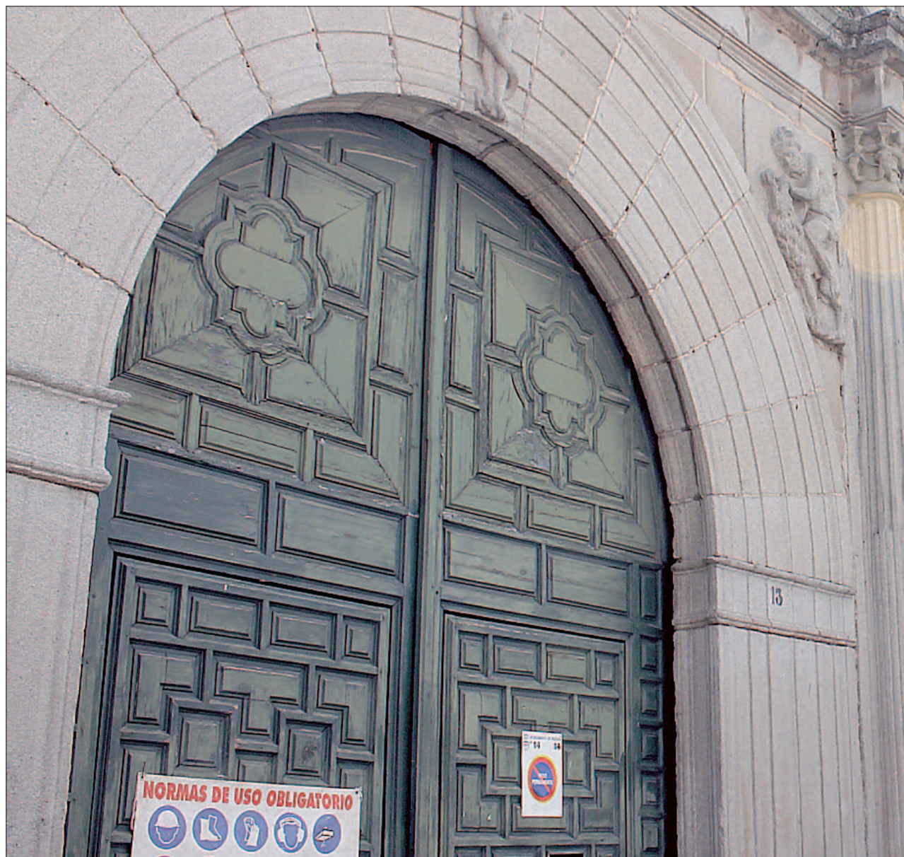
La fachada del Palacio Episcopal, donde continúan las obras de adecuación del inmueble para albergar el futuro museo diocesano de orfebrería.
