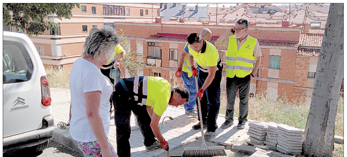
La concejala Paloma Maroto ha supervisado esta semana los trabajos de reposición de pavimento en una acera. / E. A.
