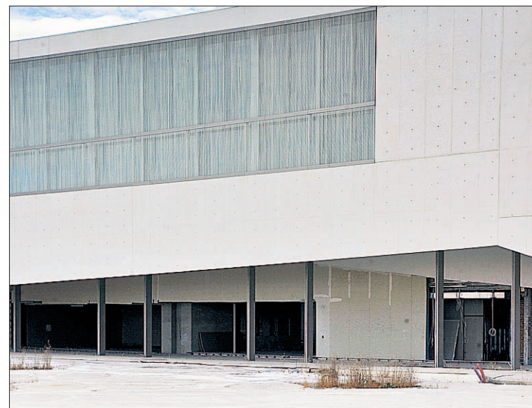
Fachada principal del edificio CIDE del Círculo de las Artes y la Tecnología. / K.
