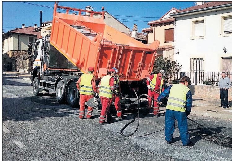
Operarios de la Diputación, realizando labores de bacheo. / EL ADELANTADO
