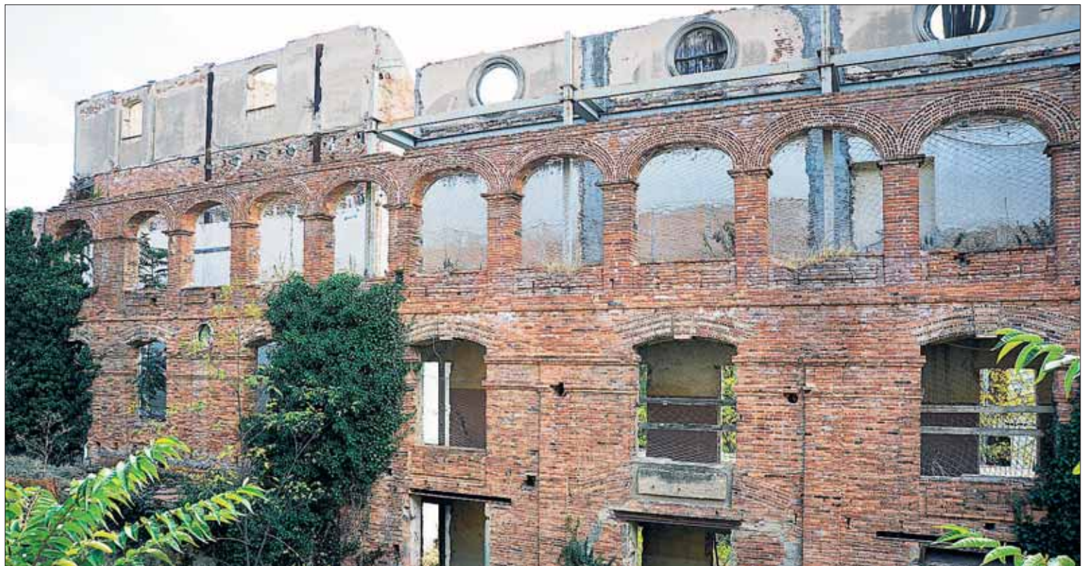
Esqueleto del edificio del Teatro Cervantes, cuya fachada da a la calle del mismo nombre, en el centro histórico de Segovia. / KAMARERO
