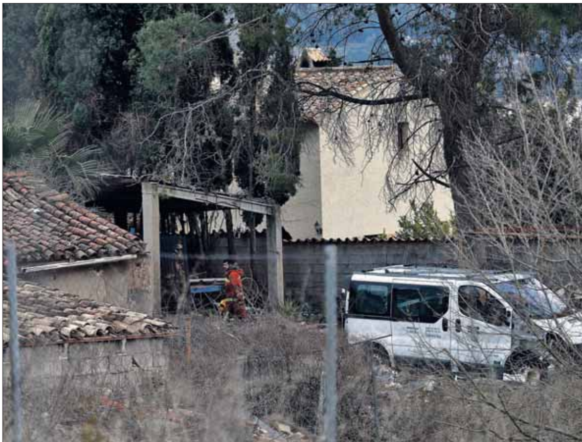
Un bombero trabaja junto a la vivienda siniestrada, en la localidad de valenciana de Ontinyent. / EFE
