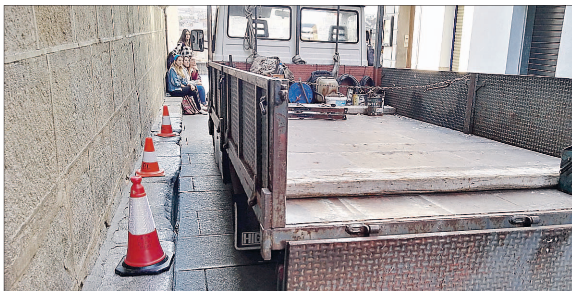
Como muestra la fotografía, los repartidores retiran los conos de la calle para poder maniobrar mejor con el vehículo.
