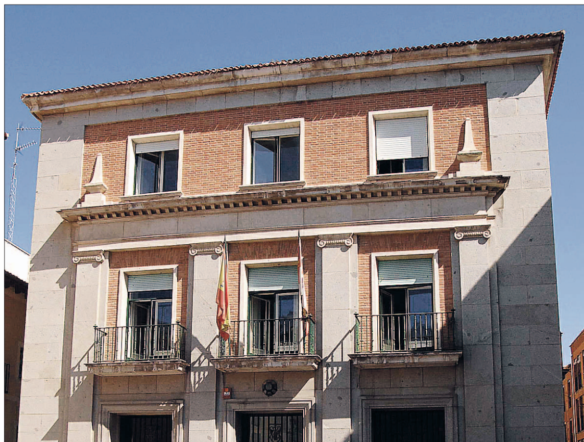
Fachada del edificio que ha sido sede del INSS hasta septiembre de 2016. / EL ADELANTADO
