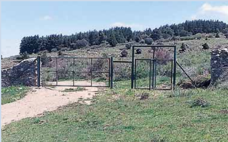
PUERTAS PARA PERSONAS Y PARA ANIMALES. Para facilitar el tránsito por el Camino Natural de la Sierra de Guadarrama se han colocado varios tipos de puertas.
