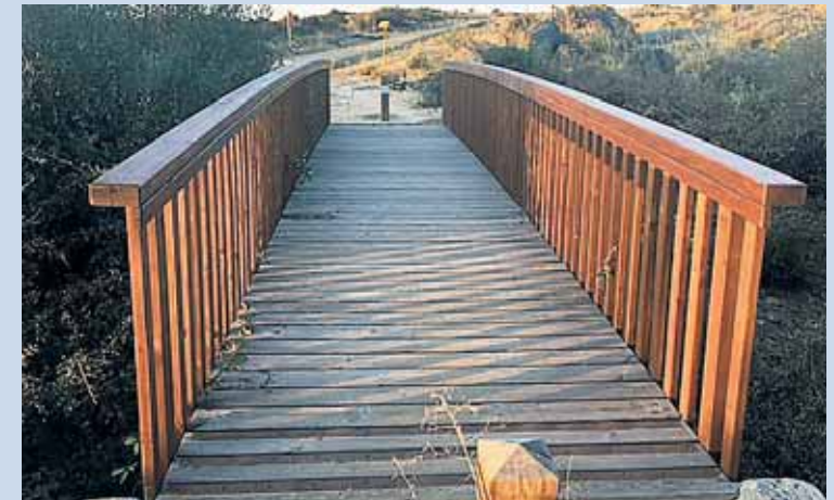
PASARELAS DE MADERA. En los puntos donde el Camino Natural debía superar algún arroyo se han instalado rústicas pasarelas de madera.
