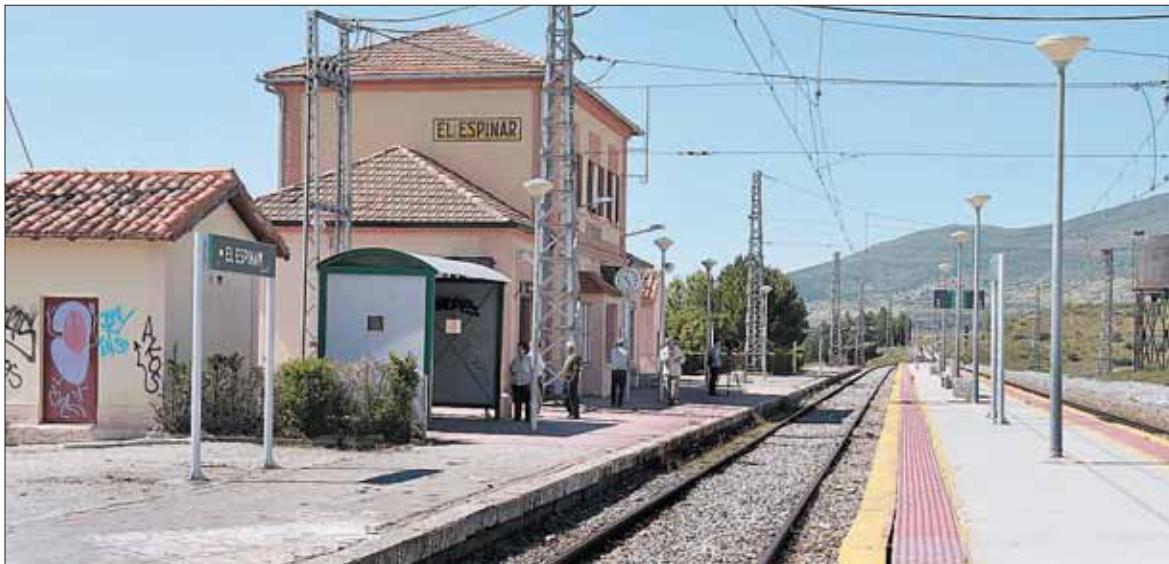
Muchas de las estaciones están deterioradas debido al paso del tiempo y al poco tráfico de viajeros. / J. MARTÍN
