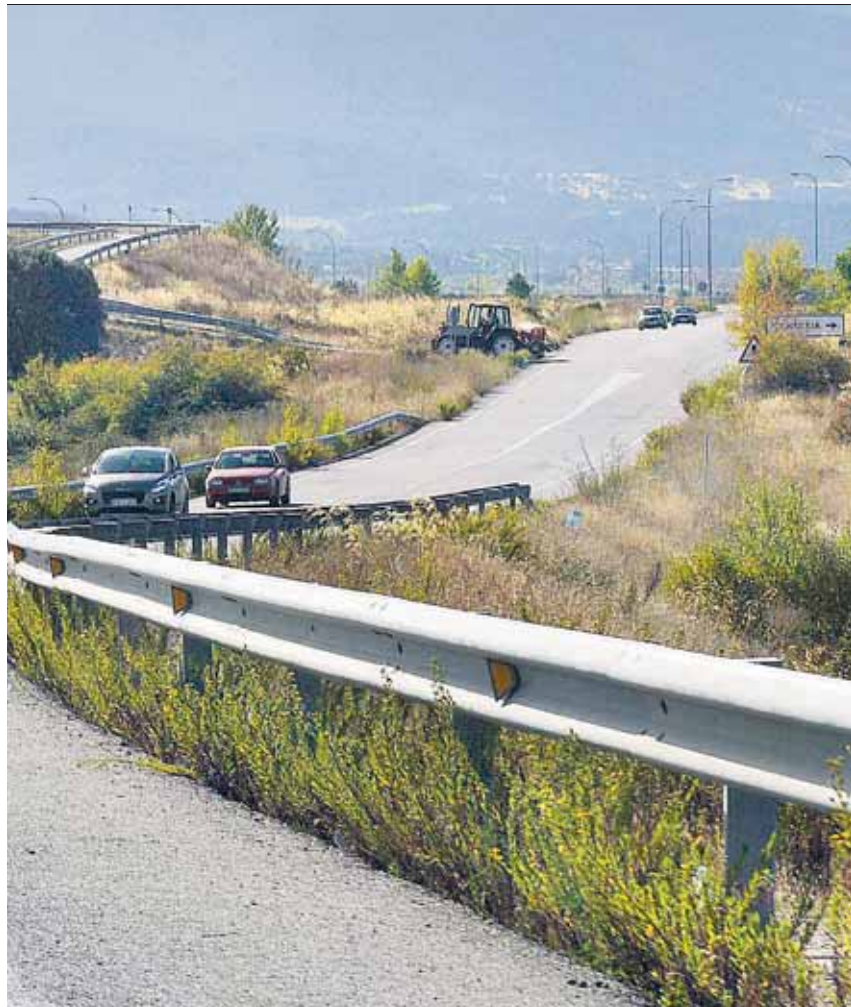
or carretera en el entorno industrial. / KAMARERO
