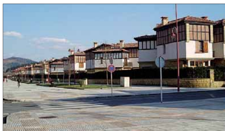
Por segmentos, las oficinas recibieron la mayor parte de la inversión. / E.P.
