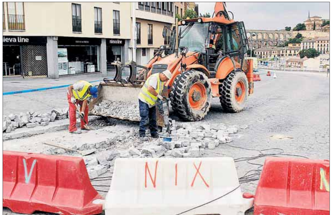
Obras ejecutadas por Isolux-Corsan en la avenida de Padre Claret. / JUAN MARTÍN
