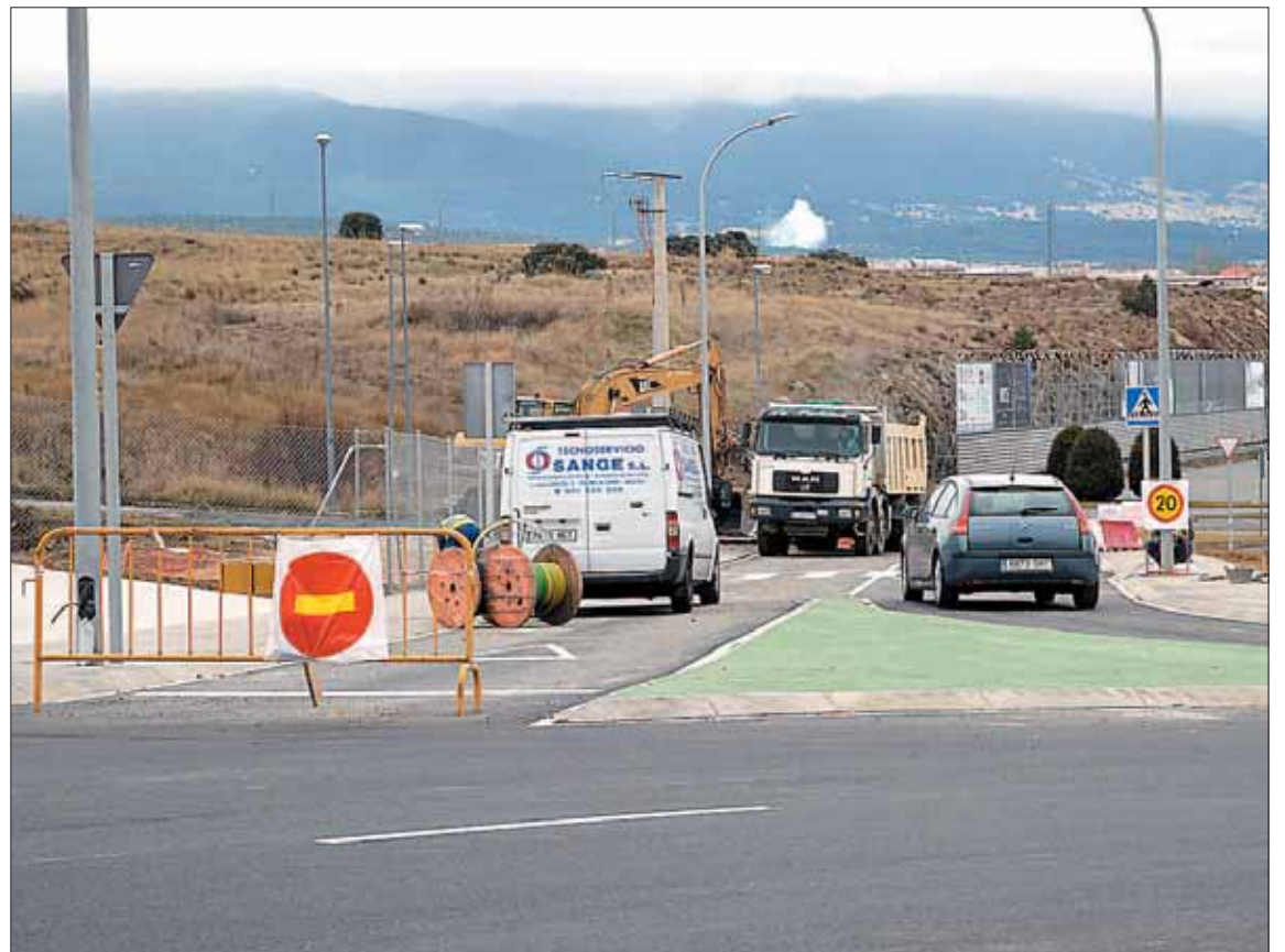
Las obras empezaron en la mañana de ayer en el vial de acceso al centro comercial. / TAMARA DE SANTOS
