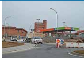
Operarios y máquinas trabajan desde ayer en la zona de la rotonda.
