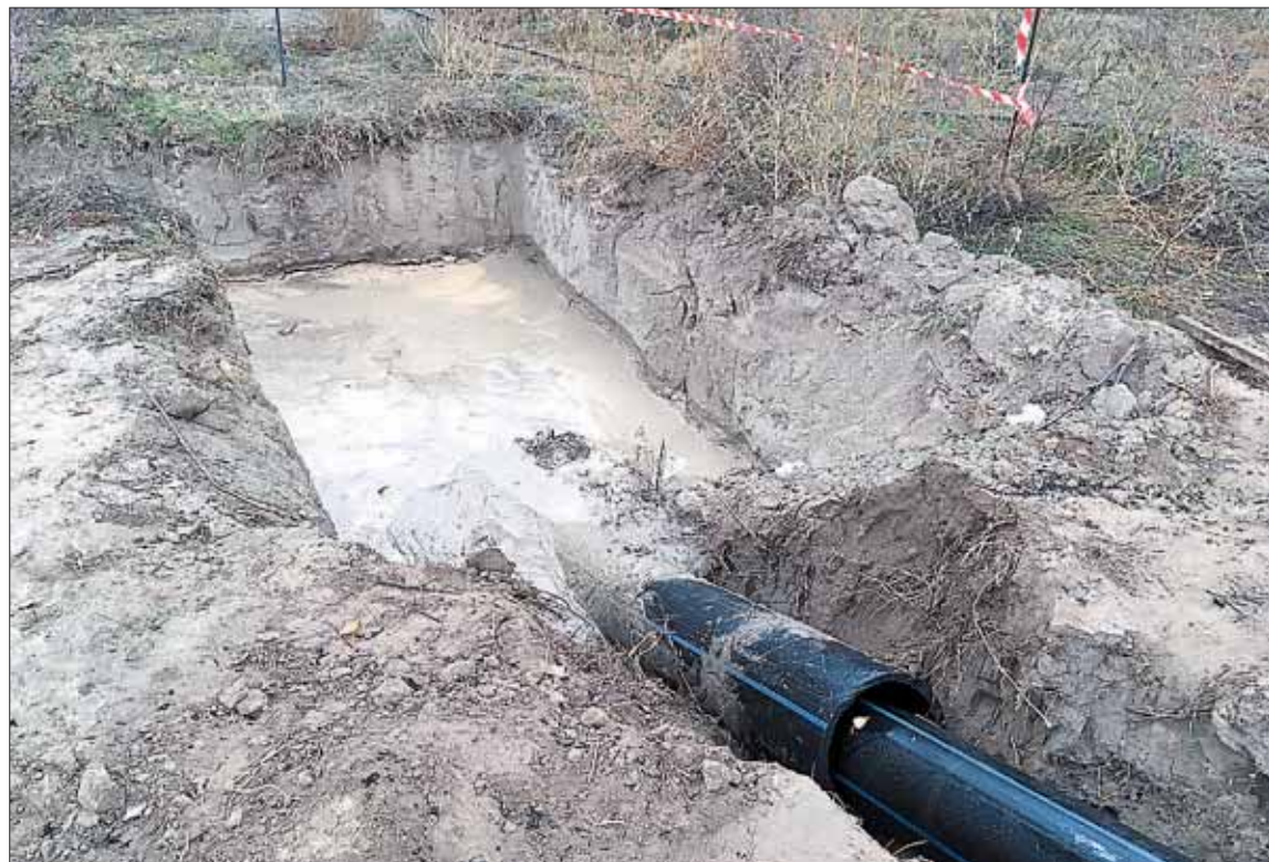
Imagen de la obra realizada junto al cauce del Eresma para instalar la tubería que suministra agua a Carbonero. / E.A.
