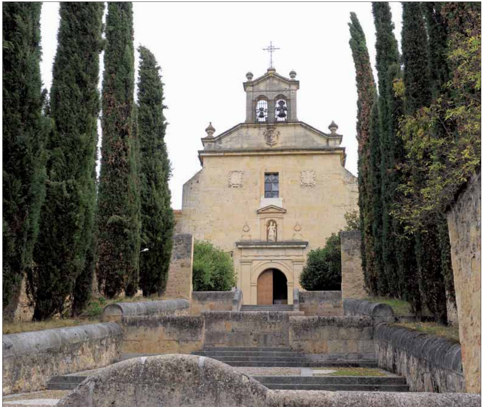
Fachada principal de la Iglesia de los Carmelitas, en Segovia. / KAMARERO
