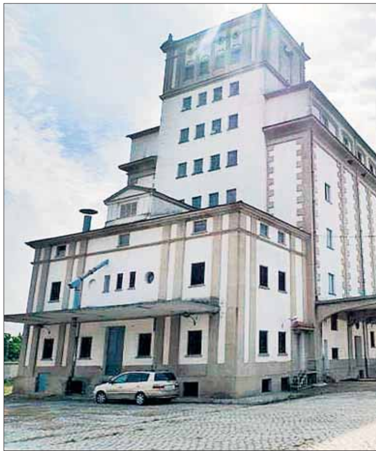
Silo situado en Mérida, uno de los que saldrá a la venta. / EL ADELANTADO
