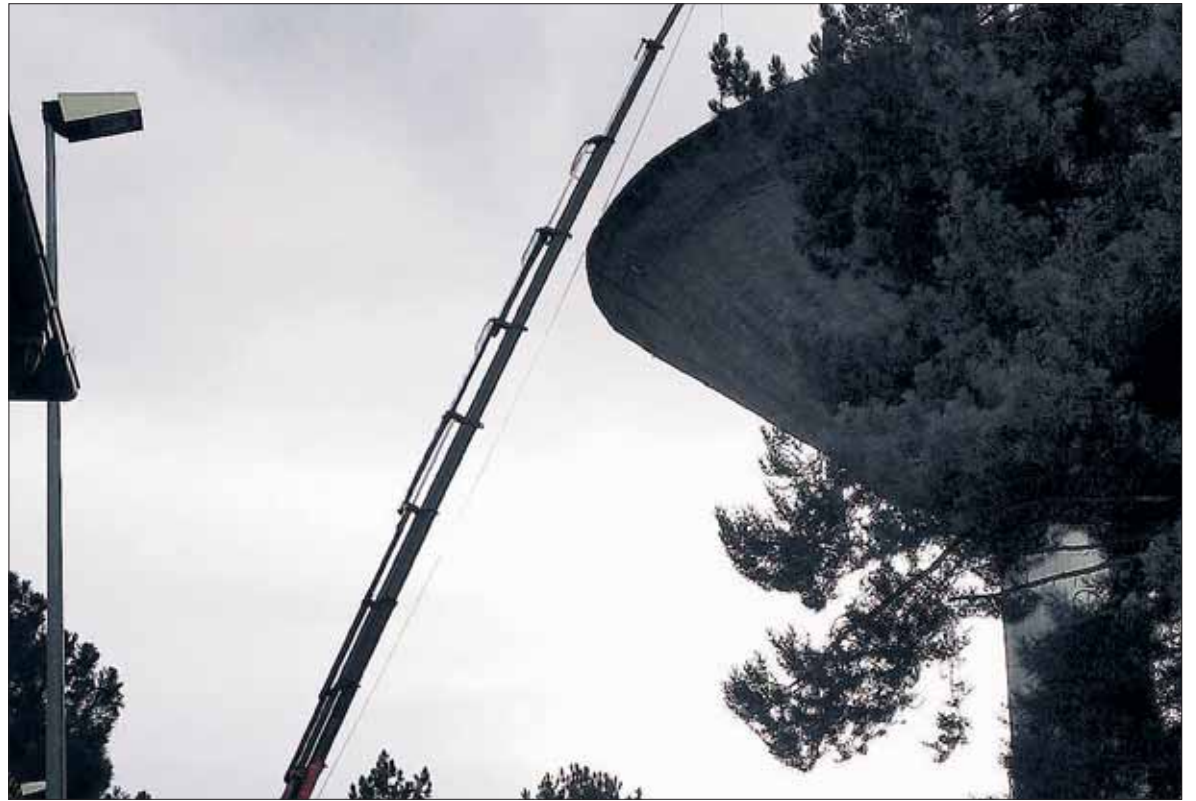
Una grúa instalada junto al depósito del agua, durante las obras realizadas en las últimas semanas. / EL ADELANTADO
