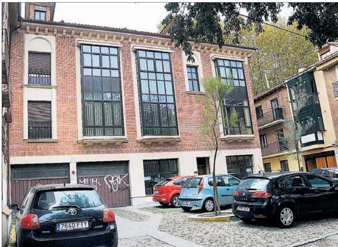
Inmueble del casco histórico conocido como casa de la parra, en la calle del mismo nombre. / KAMARERO
