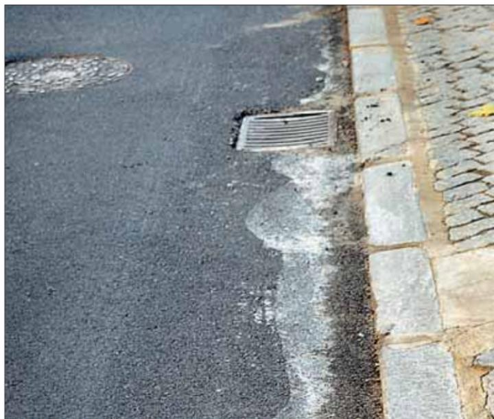
El asfalto se ha levantado, sobre todo, en las bocas de las alcantarillas. / T. DE SANTOS
