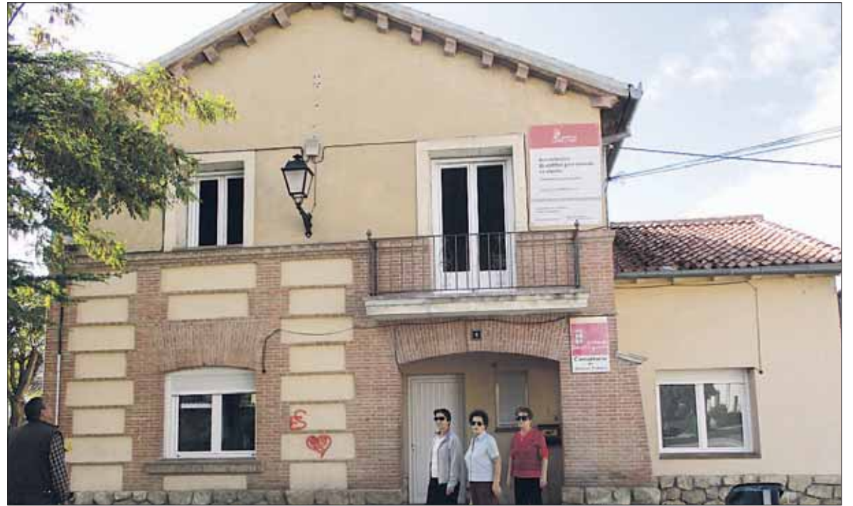
Los trabajos de rehabilitación de la vivienda avanzan a buen ritmo./ LOURDES MATARRANZ
