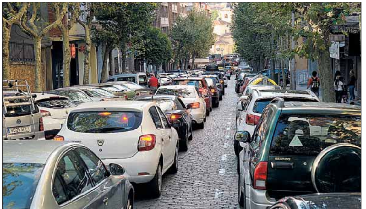
Largas filas de coches en una calle próxima a la avenida de la Constitución, durante los trabajos de asfaltado. / KAMARERO
