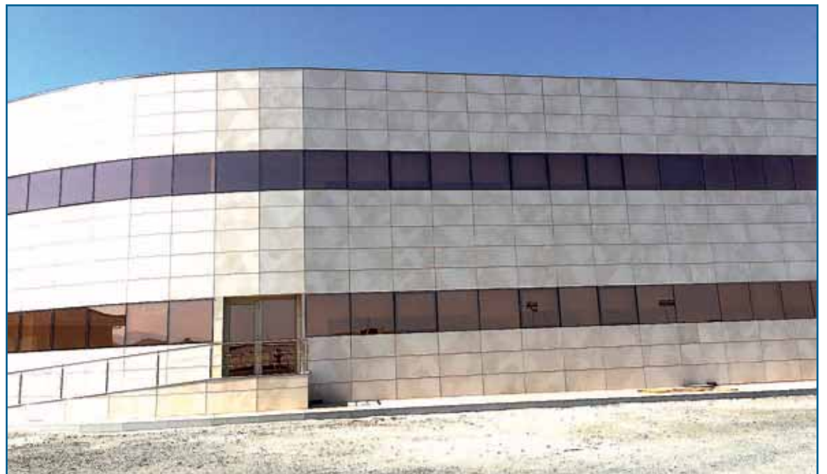
Edificio principal de 'Avícola Velasco', ubicado en el municipio segoviano de Villacastín. / A.V.
