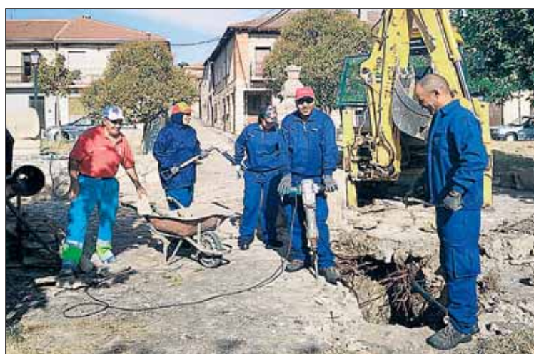
Los participantes ya trabajan en la nueva tubería, en Valdesimonte. / E.A.
