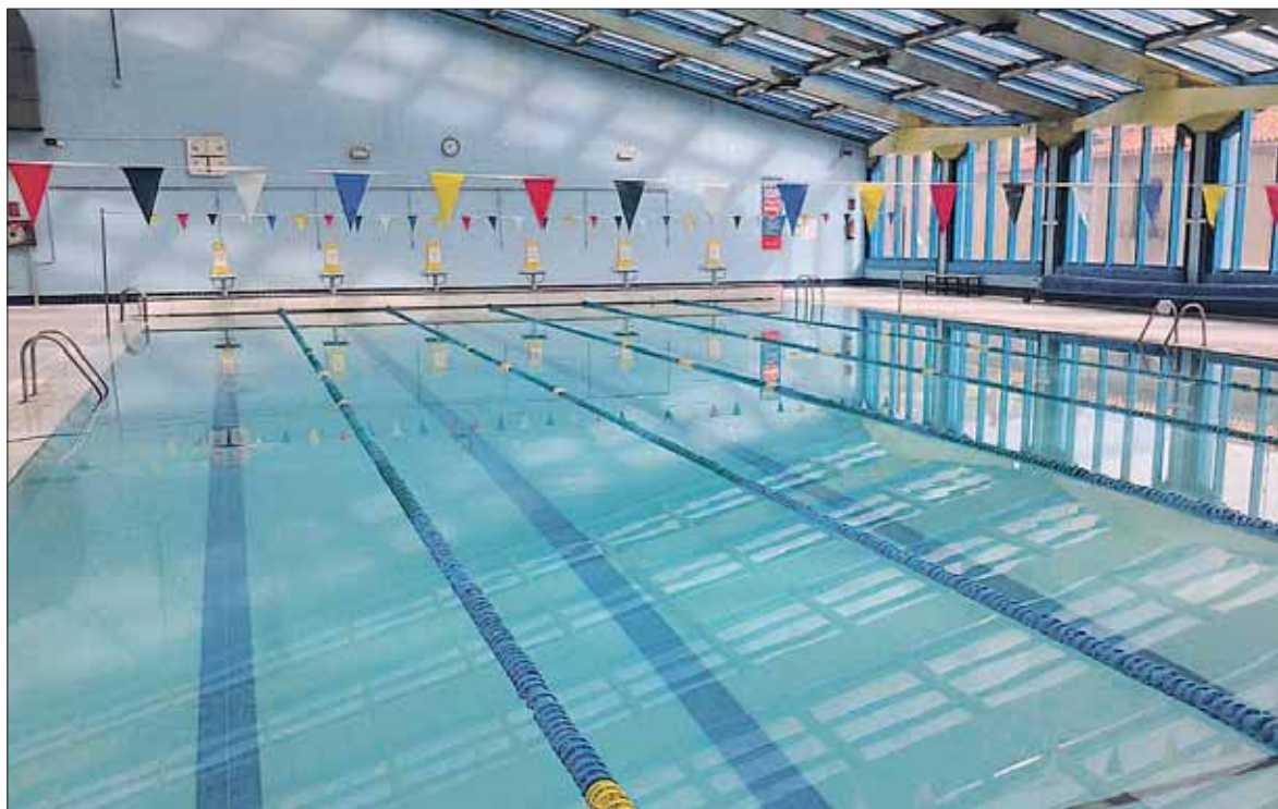
Con las obras acometidas en la cubierta mejorará el balance energético de las instalaciones. / E. A.
