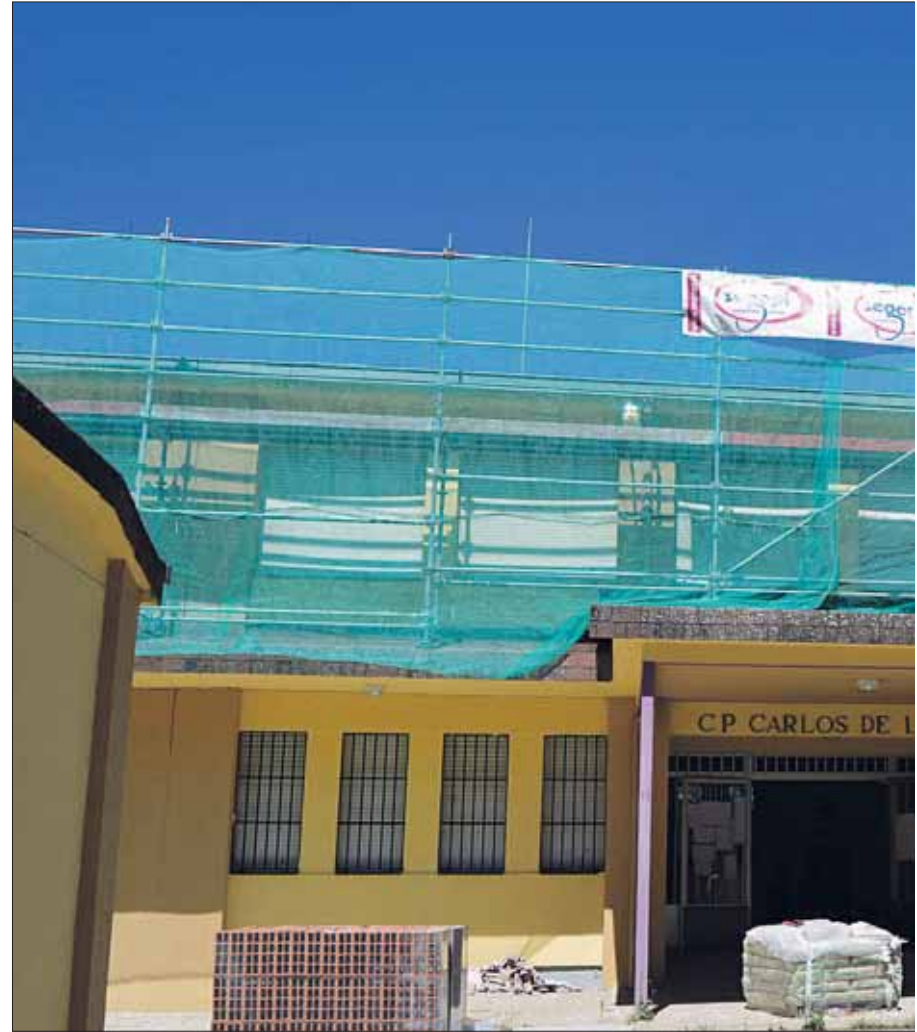
Obras en el colegio público 'Carlos de Lecea', en Segovia, este verano. La Junta esgrime que al ser lo
