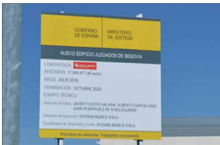
El cartel anunciador de la obra ya luce en la parcela. / TAMARA DE SANTOS
