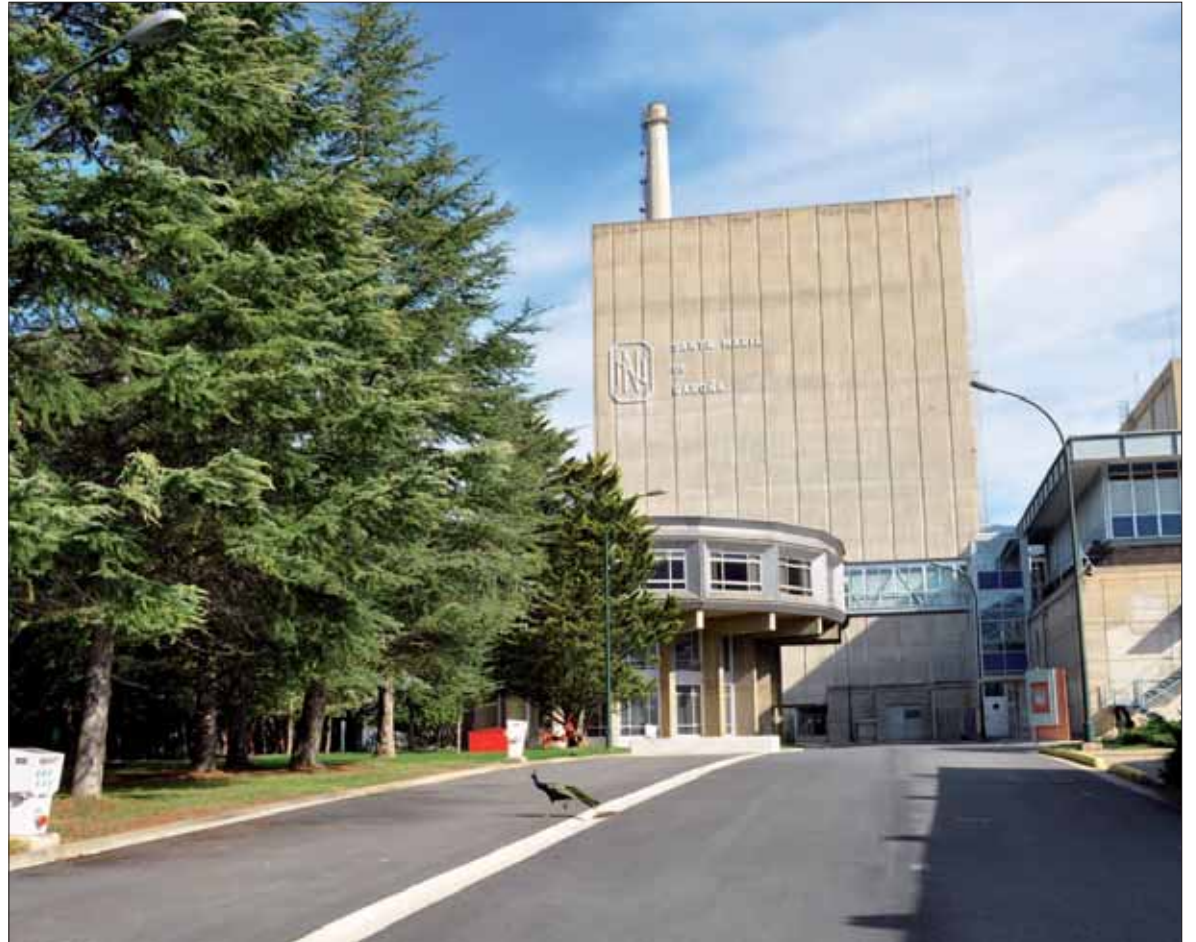
La fase de predesmantelamiento concluiría con la extracción del combustible de la piscina. / EUROPA PRESS
