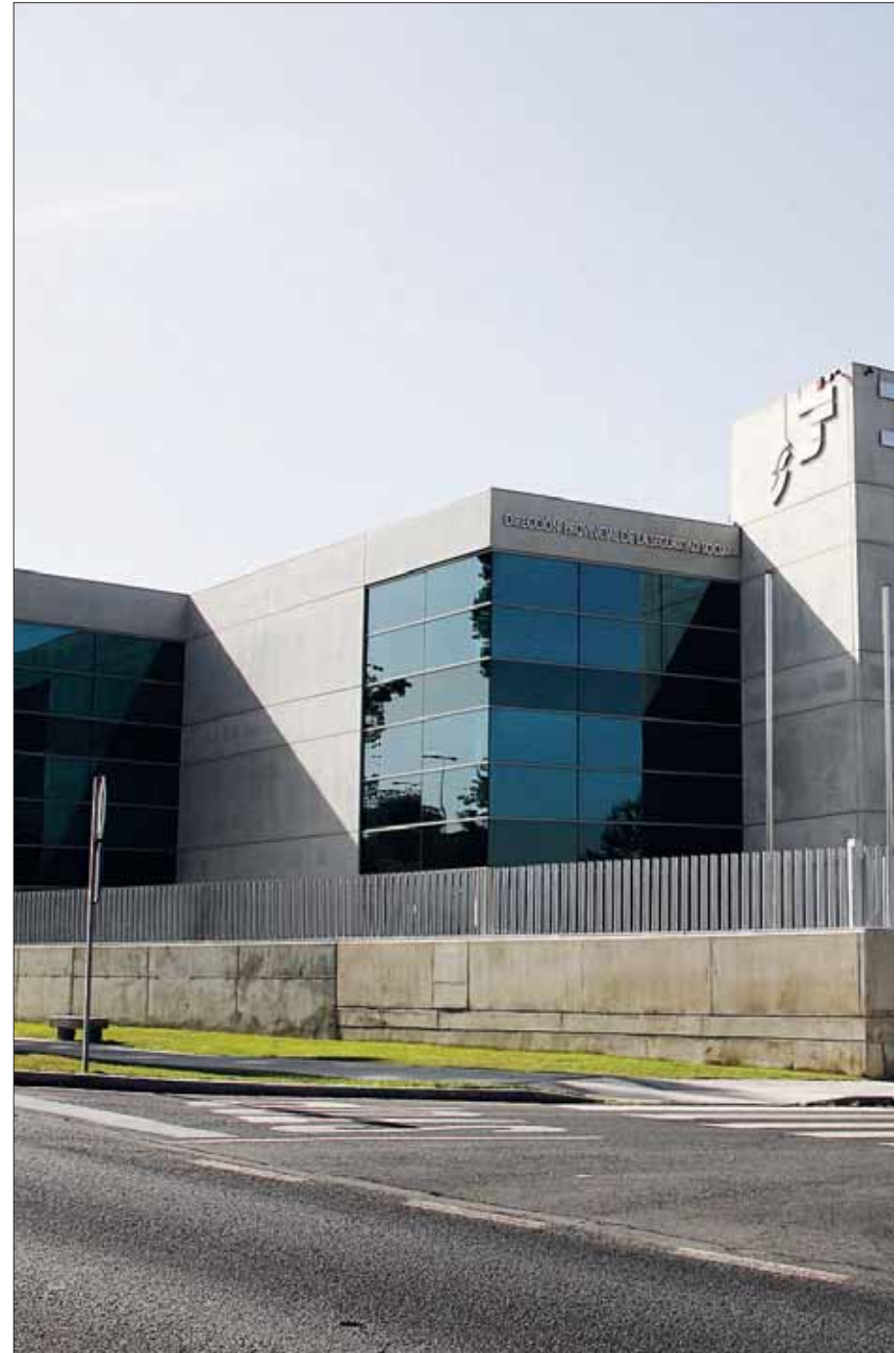
El nuevo edificio, ya construido, comenzará a prestar sus servicios al público el 27 de septiembre
