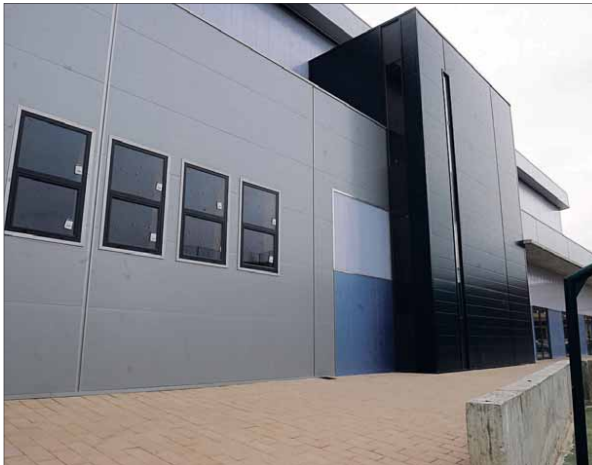
Imagen lateral del exterior del pabellón de Nava de la Asunción a medio terminar. / KAMARERO
