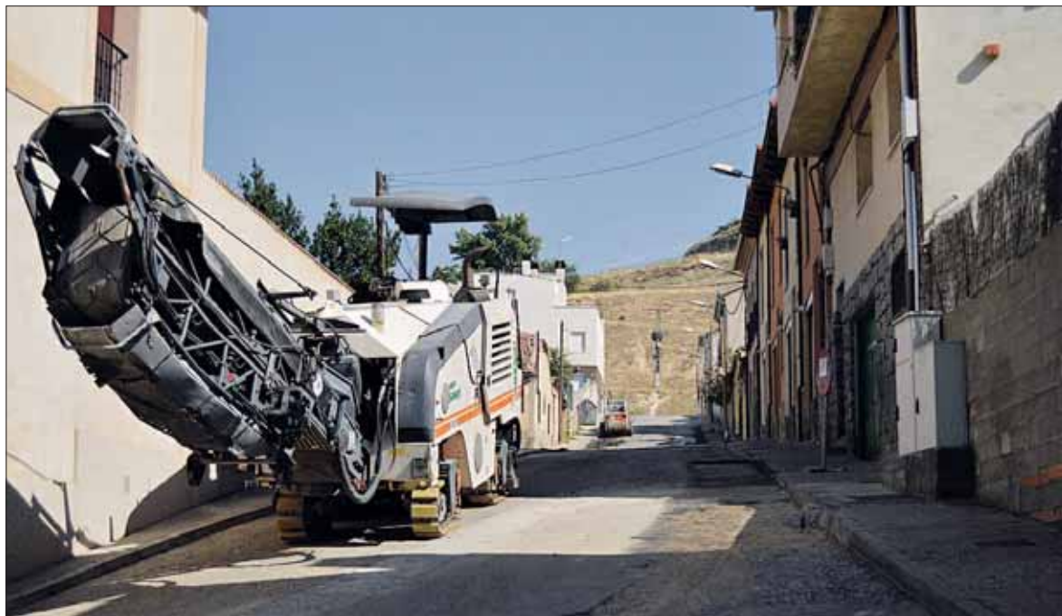
Primeros trabajos en la confluencia entre la calle del Rosario y la del Río Cega, en San Lorenzo. / CRISTINA YUSTA
